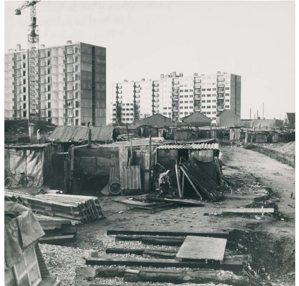
Nanterre, el barrio pobre de Pâquerettes en proceso de demolición. Al fondo, la construcción de la Cité des Canibouts (entre 1959 y 1961) © H. Guérard / Adoma
